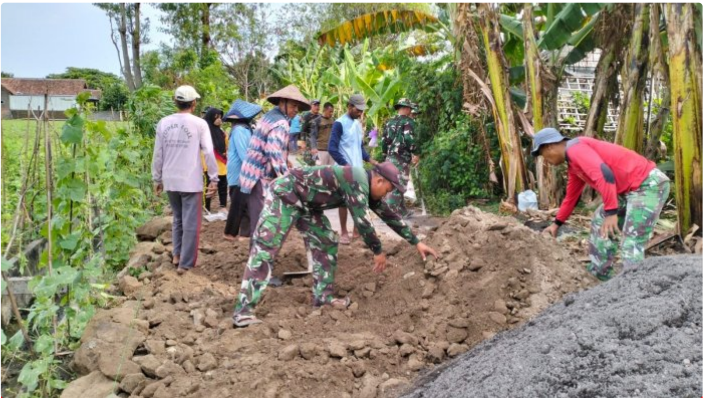
Peduli Jalan Rusak Di Wilayah Binaan, Babinsa Bersama Warga Karya Bakti Timbun Jalan.
